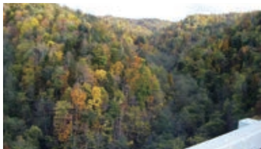
⑨ ウルベシ橋 URUBESHI BRIDGE
